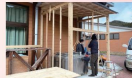
2月6日時点のバイogasプラント まずは断熱するための建屋から製作!
